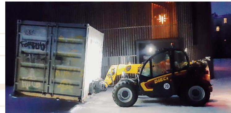
Abholung des Containers im Januar 2026 um 6.00 Uhr morgens bei minus 10 Grad. Hier hinter der Kapelle soll das neue Garwehaus entstehen. Foto: Ute Zimmermann
